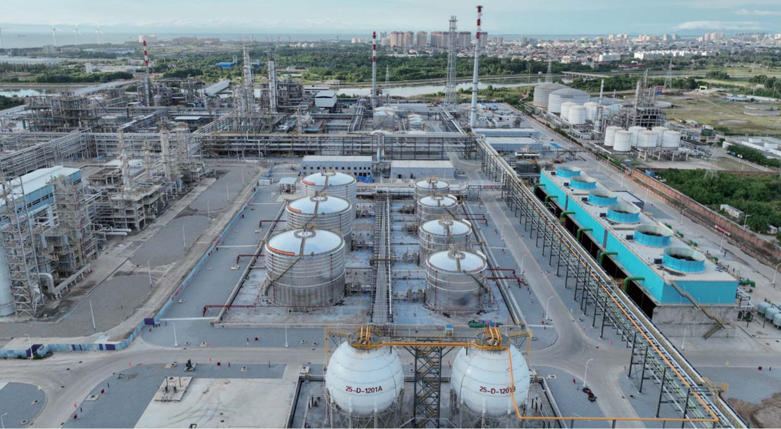
■ 丙烯腈裝置局部
