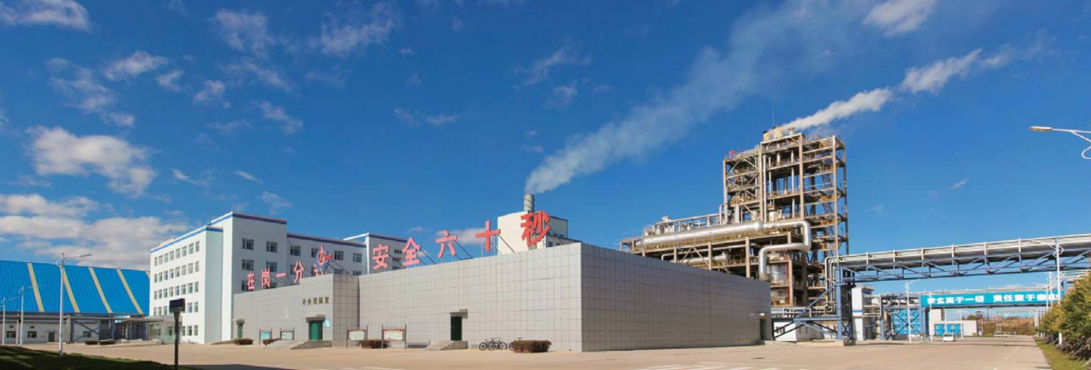
■ 華鶴煤化工尿素裝置 中央控制室
