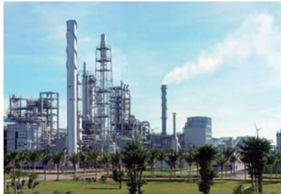
海南生產裝置
